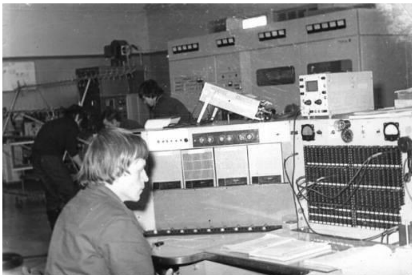
Остров Диксон, радиопередающий центр УГМС. центральный пульт управления и коммутации радиопередатчиков
