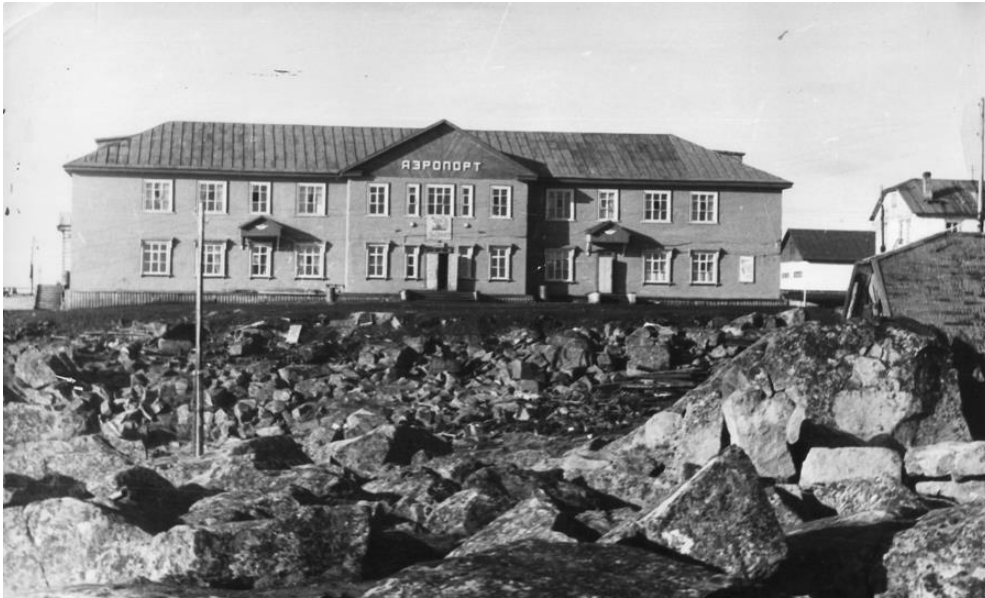
Здание аэропорта Диксон
