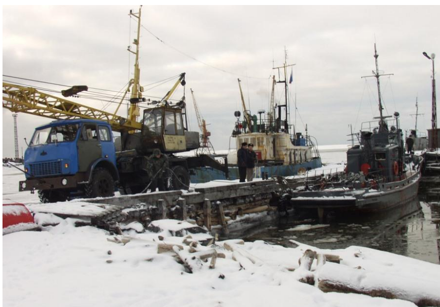
На пирсе кипит работа
