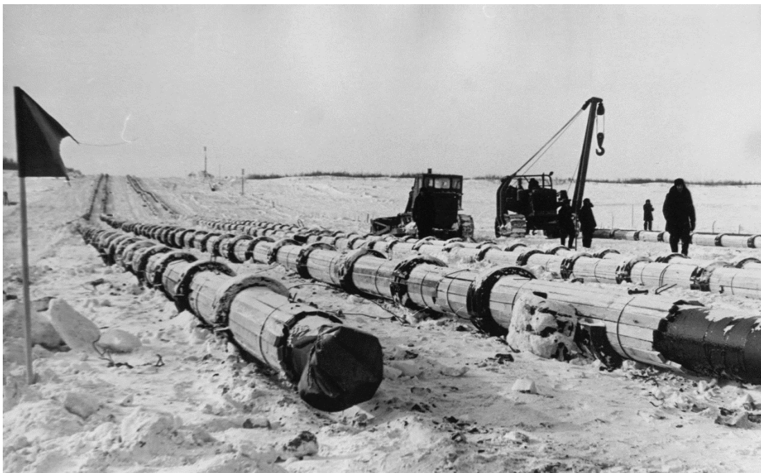
Строительство газопровода Мессояха-Норильск
