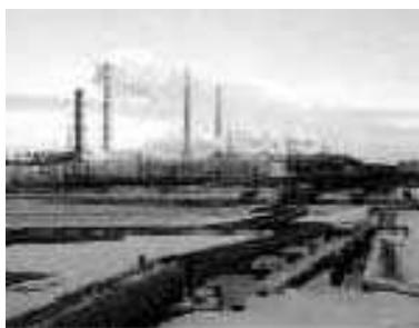
Надеждинский металлургический завод открылся в 1979 году. Завод имеет два производства – гидрометаллургическое и пирометаллургическое. Готовая продукция завода – файнштейн, аноды медные и элементарная сера. Файнштейн отправляется на дальнейшую переработку на Никелевый завод и комбинат «Североникель», анодная медь – на Медный завод.
